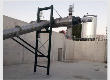
Schrägförderschnecke mit Stopfschnecke
